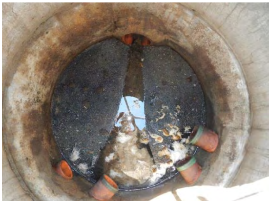
Manhole bottom before:
